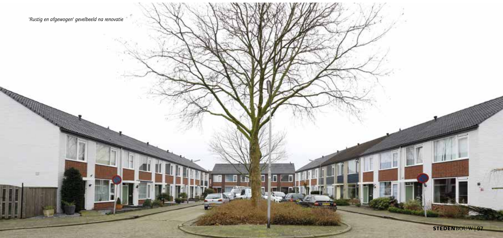
Steenstrips met baksteen-look op prefab panelen
