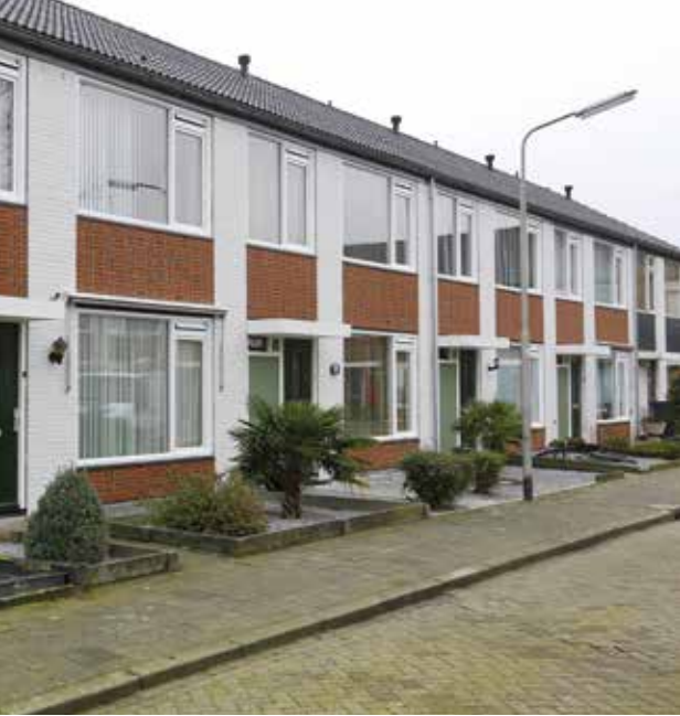
Na de kozijnmontage werden de borstweringen tussen en onder de kozijnen voorzien van de panelen met steenstrips
