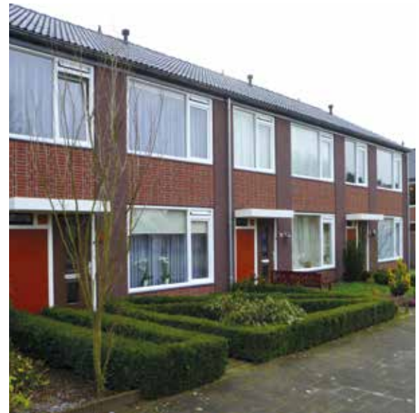
Steenstrips met baksteen-look op prefab panelen
